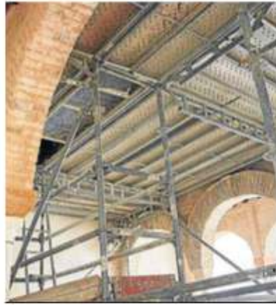
El patio de la Casa de la Contaduría, con andamios.
